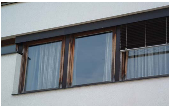
Mit den mehr als notwendigen Sanierungsmaßnahmen der restlichen Flächen des Rathauses wird nach über 30 Jahren im Herbst dieses Jahres begonnen werden - Fertigstellung Herbst 2009
